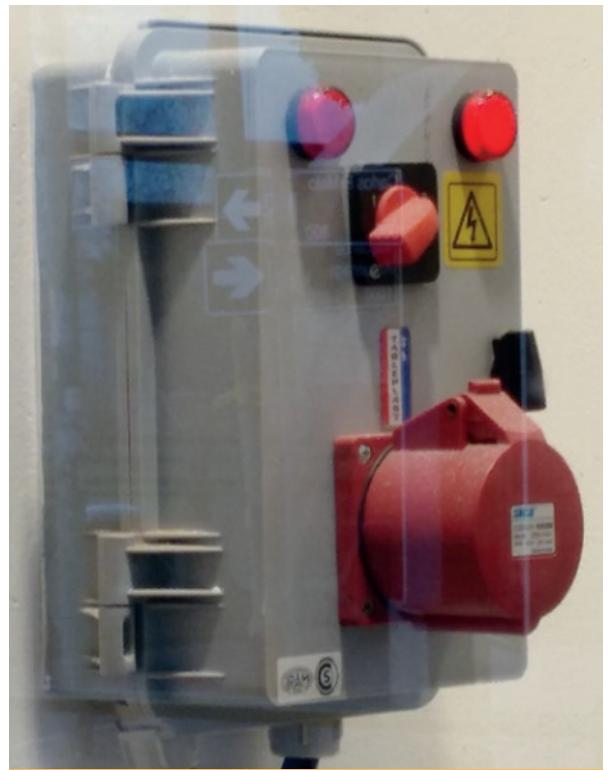
El tablero de transferencia manual (TRN) permite insertar con rapidez y seguridad un grupo electrógeno propio, alquilado o comunitario sobre el circuito de servicios esenciales (ej., ascensor de servicio, bomba de agua, heladera de medicamentos).
