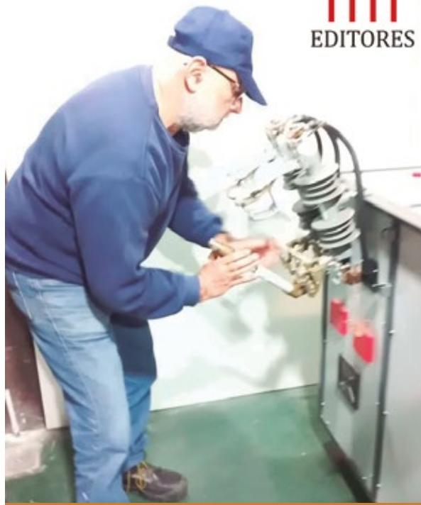
Desarrollo conjunto nacional para el ensayo de elementos fusibles
